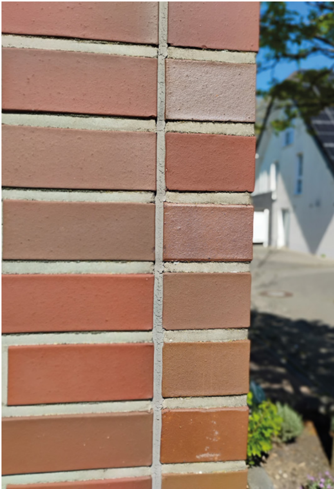
Klinkerfassade mit Eckfuge ohne Risse
